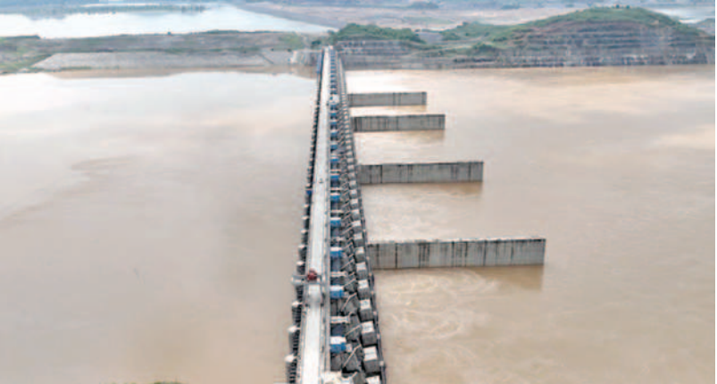
శనివారం పోలవరం ప్రాజెక్టుపై భారీగా చేరిన గోదావరి వరద
